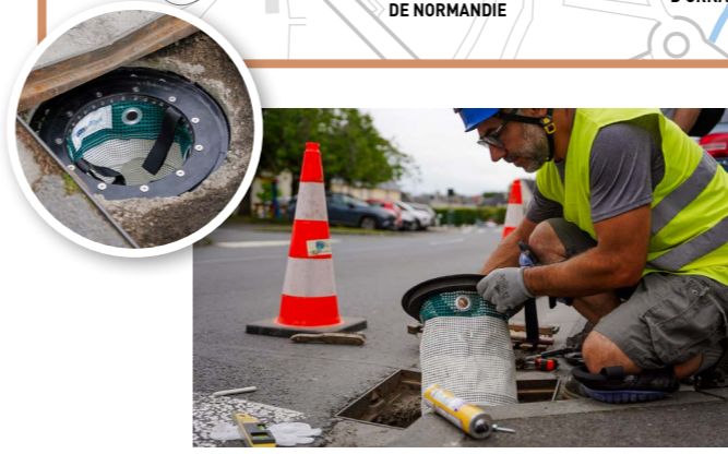
En juillet dernier, des paniers anti-déchets ont été installés sur les grilles d'évacuation des eaux de pluie. Ils permettent de retenir notamment les mégots avant que ceux-ci n'atteignent nos mers et nos rivières.
